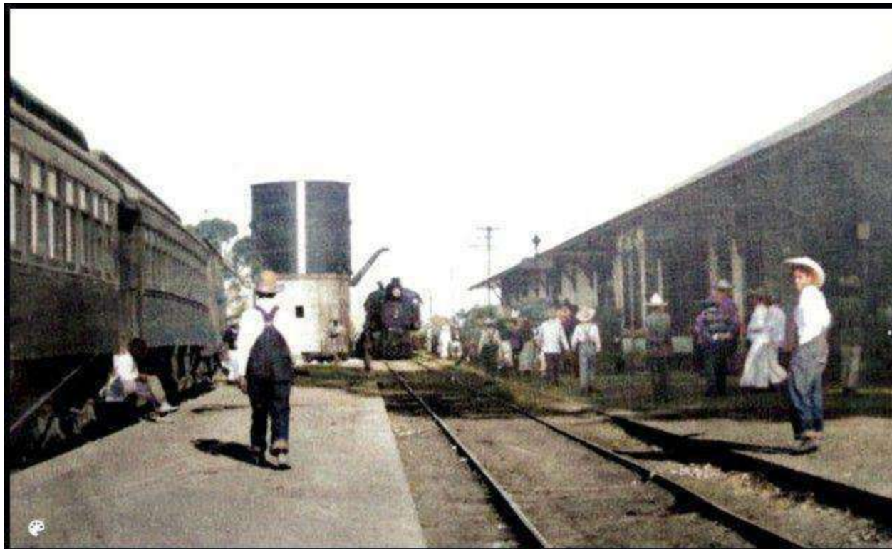
LA ANTIGUA ESTACION DEL FERROCARRIL EN OCOTLÁN, JALISCO. IMPORTANTE ENTRONQUE PARA ATOTONILCO EL ALTO, PARA GUADALAJARA Y LA CIUDAD DE MÉXICO.
